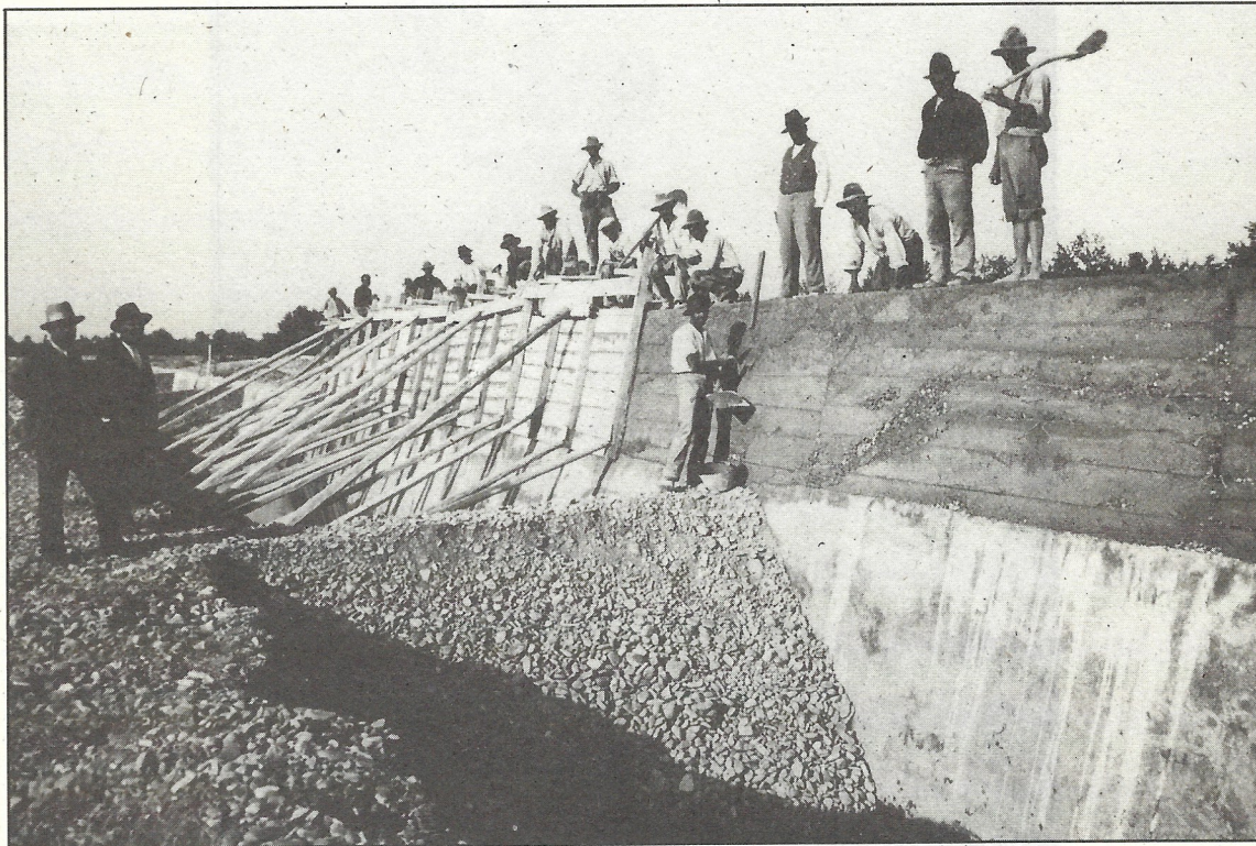
1932, S. CESARIO SUL PANARO Costruzione di arginature sulle rive del fiume.
