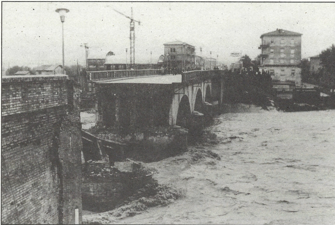
1966, VIGNOLA Il crollo del ponte Muratori il 4 novembre.
