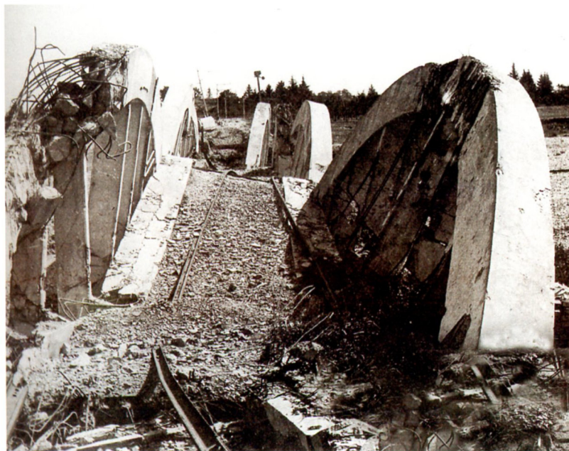
1945. Bazzano, il ponte sul Samoggia completamente distrutto durante la seconda guerra mondiale.
