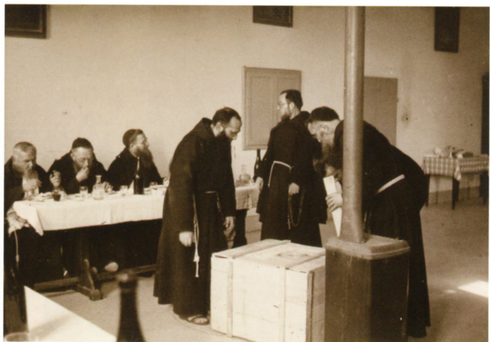
1954. Nel refettorio del convento si sta aprendo la cassa che contiene il nuovo ostensorio commissionato da p. Ugolino da Niviano e alcune pissidi fatte dorare e argentare di nuovo. Da sinistra si riconoscono p. Vito, p. Salvatore e fr. Riccardo. (Parma, Archivio provinciale cappuccini)
